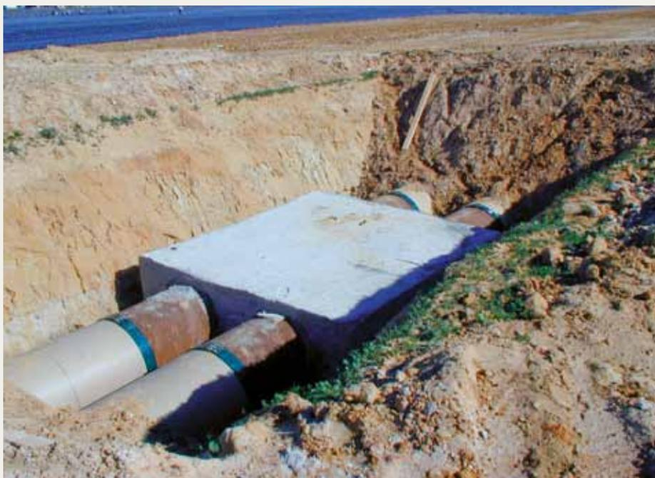
Raccordement de tubes en polyester à des tubes en acier de diamètres extérieurs différents à l'entrée et la sortie d'un regard.
